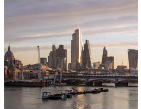
22 Bishopsgate / イギリス・ロンドン
