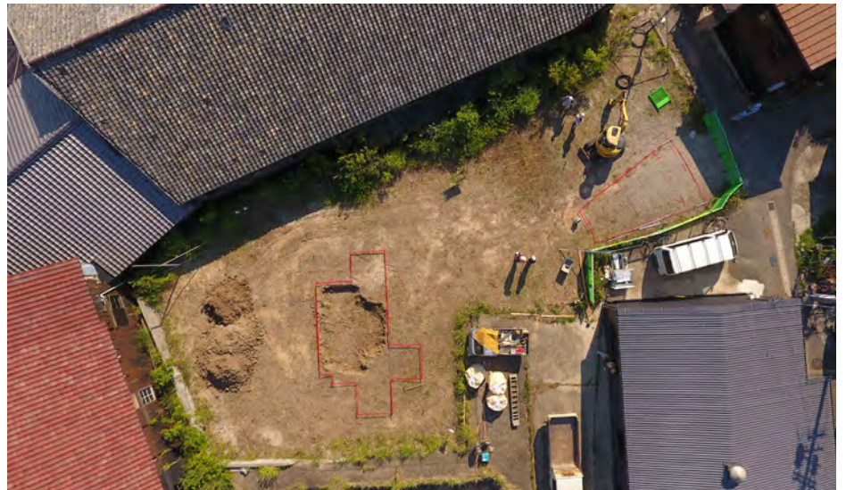
やきもの工場に囲まれた会場。2022年7月初旬・施工前の撮影
